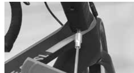
トランジションプレートのボルトを締めます
