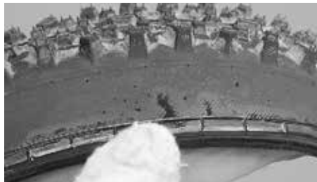
Kostuta renkaan jalkaosa saippuavedellä ennen asennusta
