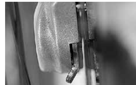
Kontrollera slitaget på beläggen
